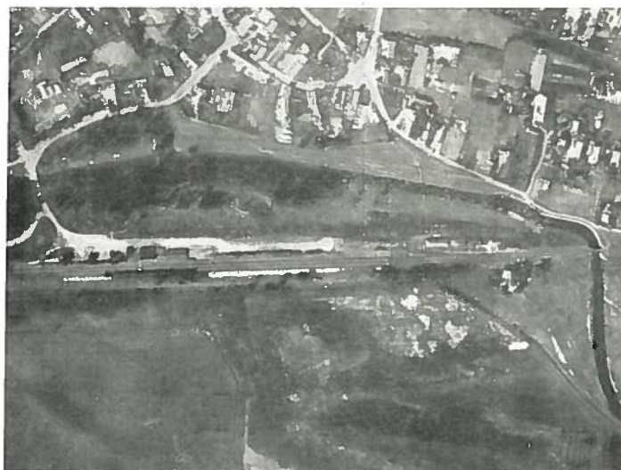
Vasúti híd nagyobb csatornán (továbbá egy kis vasúti állomás, csatorna és út keresztezése)
